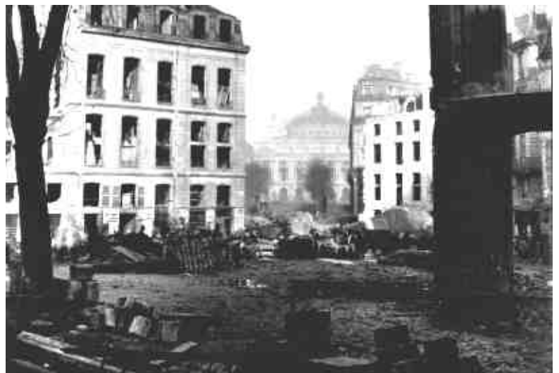
Travaux place de l'opéra, sous la direction du baron haussman, Paris, 1860
